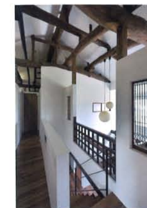
2階の天井。壁の一部には、以前の戸にあった飾りを活かしている。
